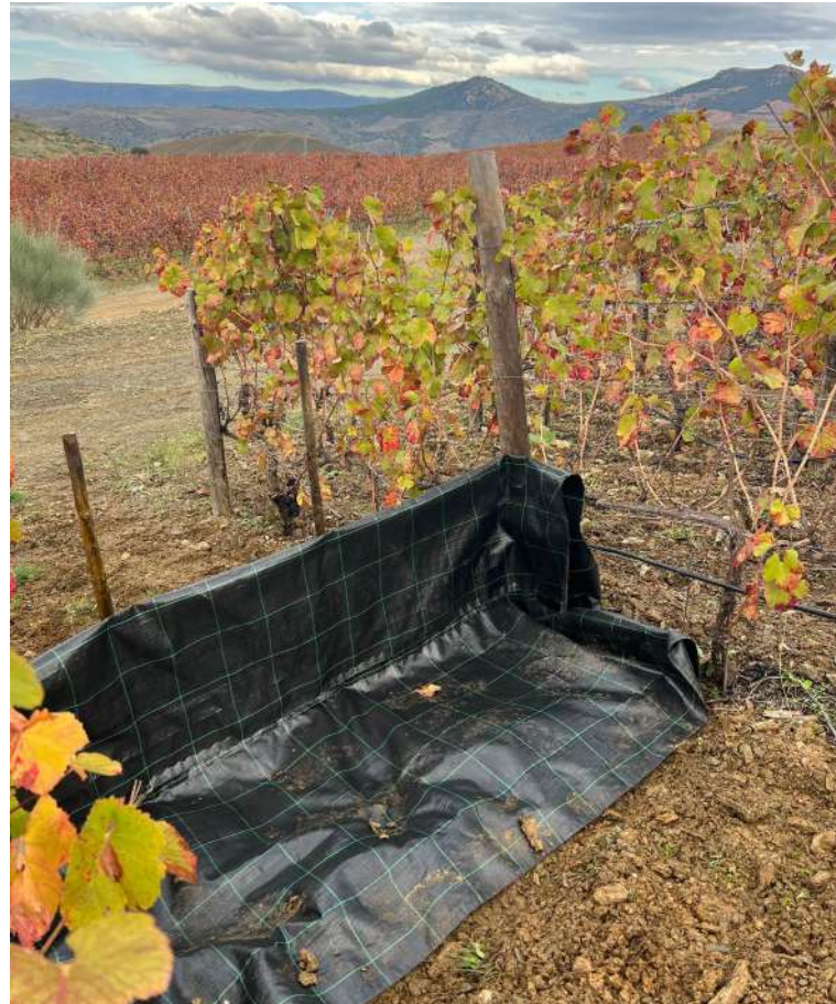
Instalación de tela para retención de suelo
